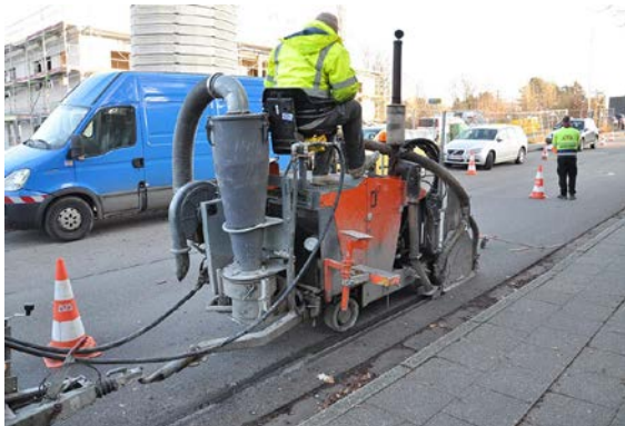
Abbildung 12: Nano-Trenching
