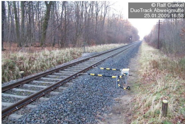
Abbildung 20: Kabelmontage an Schienenwegen – hier mit Abweigmuffe
