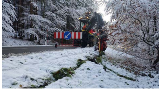
Abbildung 5: Einsatz des Kabelpflugverfahrens unter erschwerten Witterungsbedingungen
