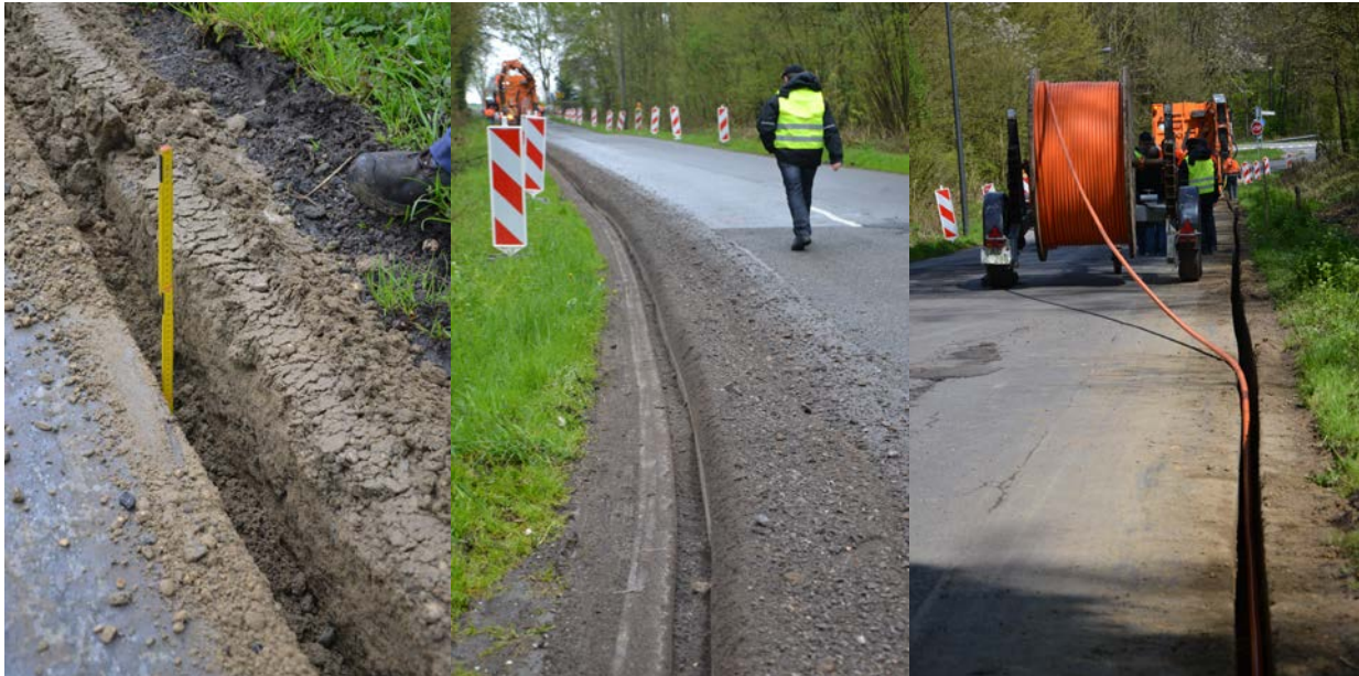
Abbildung 11: Mini-Trenching und die Verlegung von Kabeln bzw. Leerrohren
