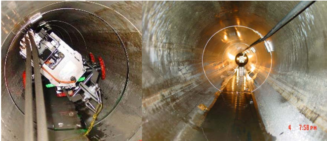
Abbildung 15: Verlegung im Abwasserkanal mit Verlegeroboter
