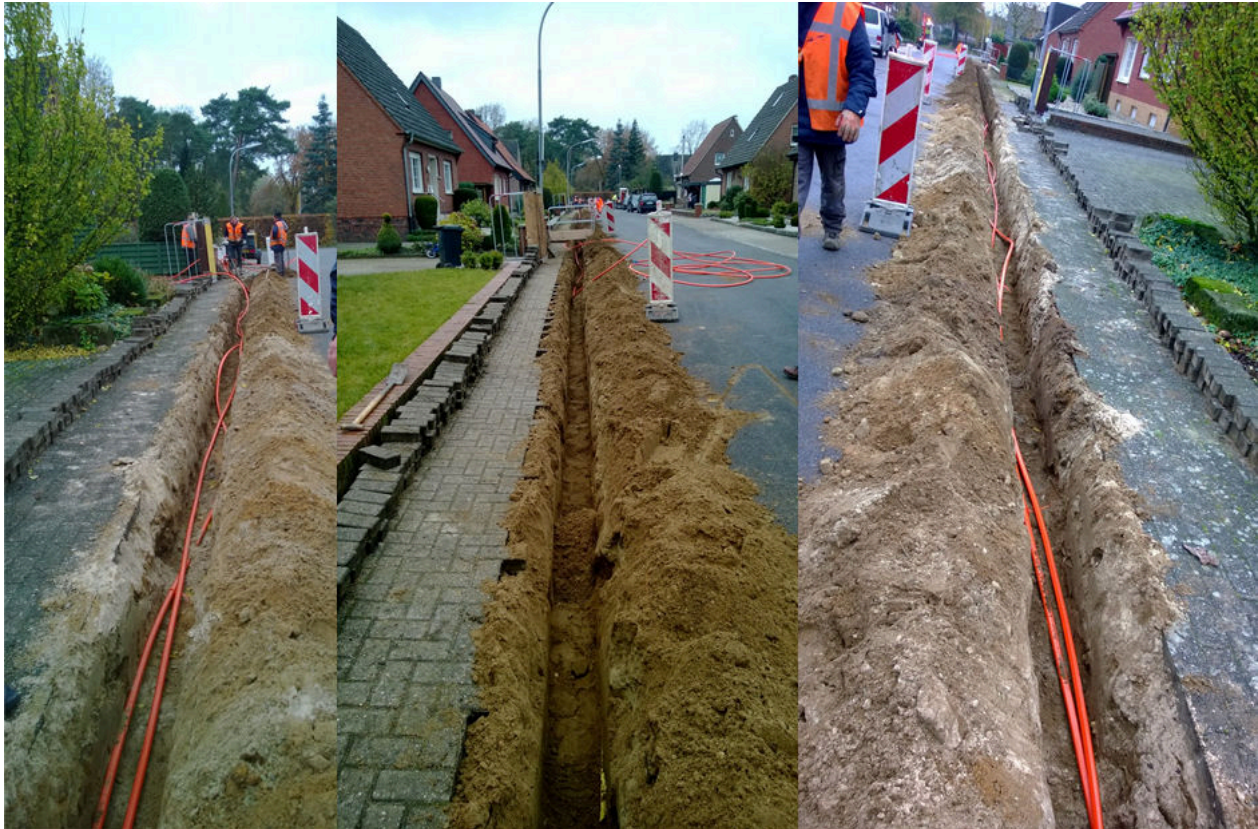
Abbildung 1: Offene Verlegung in leicht reduzierter Tiefe
