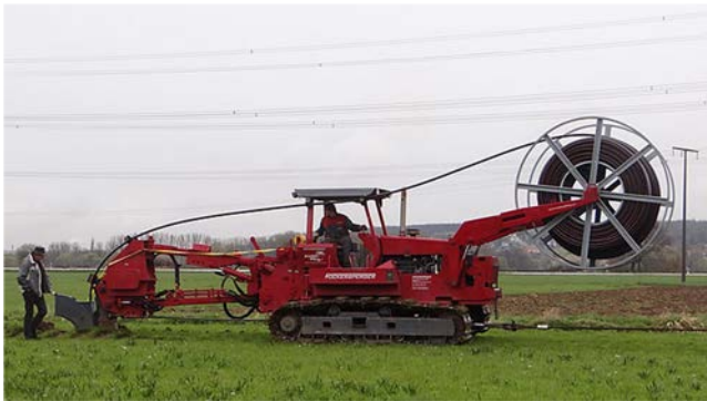
Abbildung 2: Anwendung des Kabelpflugverfahrens für Energieleitungen
