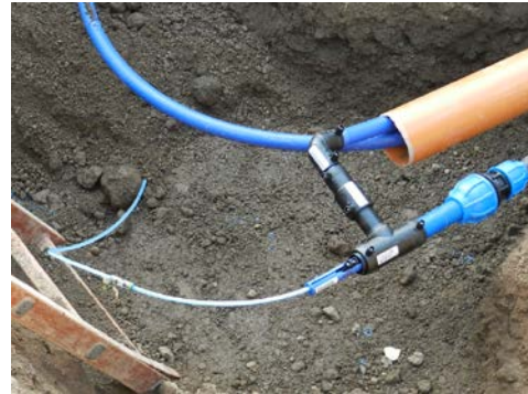
Abbildung 18: Verlegung in Gas- und Frischwasser- leitungen
