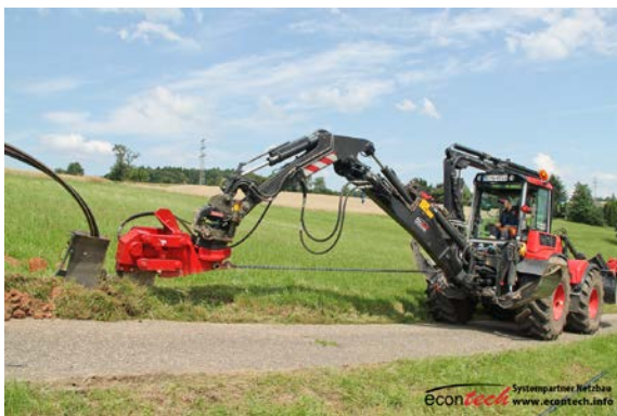
Abbildung 4: Peter-Kabelpflugverfahren
